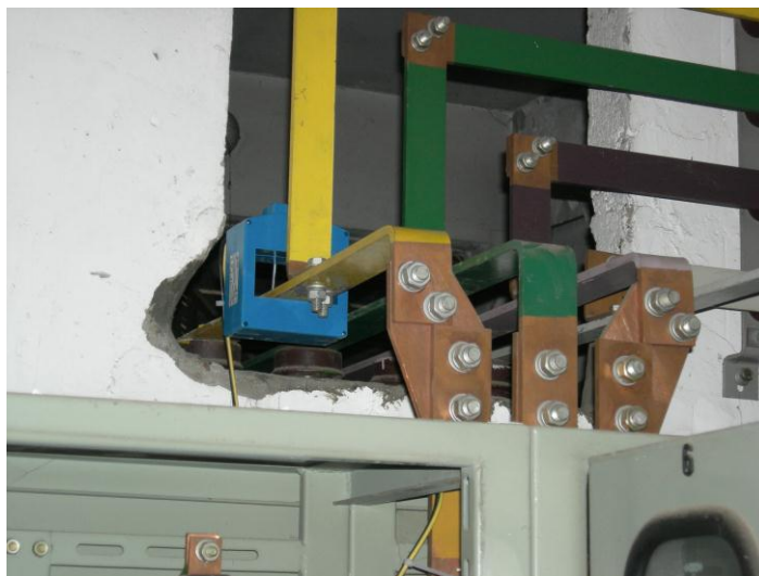
Slika 5: „Signalno“ priključenje ormana kompenzacije
