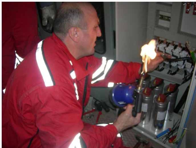
Slika 4: „Energetsko“ priključenje ormana kompenzacije
