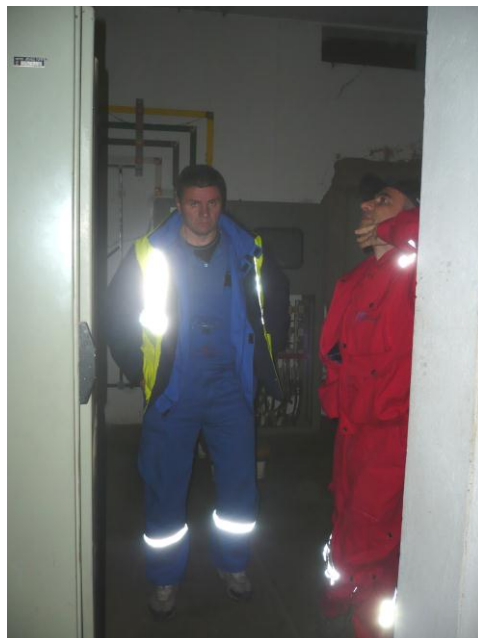
Slika 3: Ekipa EDB-a isključuje trafo-stanicu
